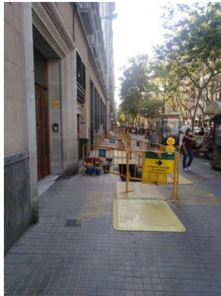
14. Vista general de la rasa front els núm. 80-74
