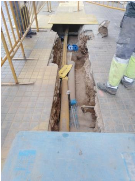
13. Col·locació del nou tub front els núm. 80-74
