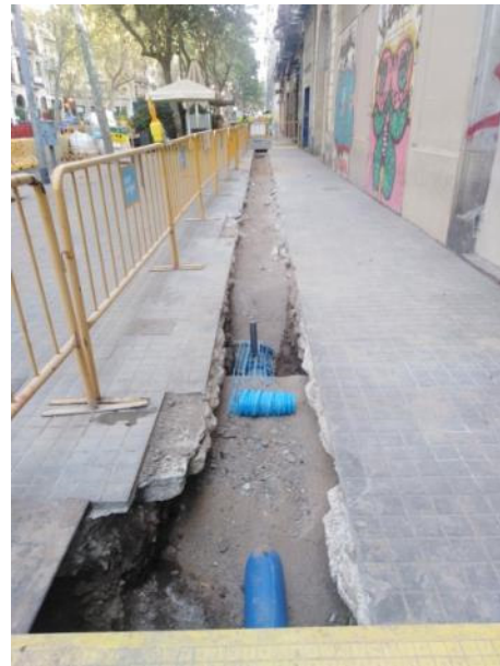
8. Rebliment de la rasa front el núm. 46.
