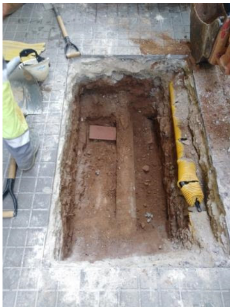
3. Cata de comprovació de serveis front el núm. 72-56
