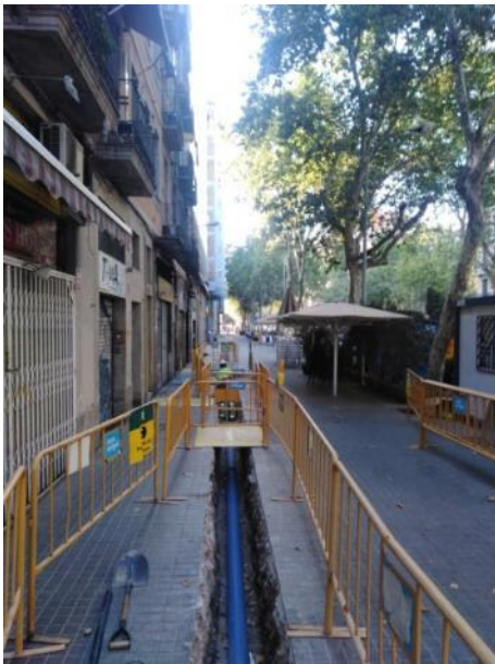
7. Vista general de la rasa front el núm. 72-56
