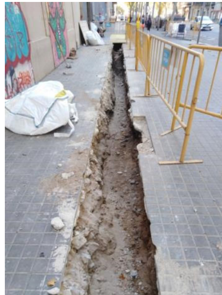
6. Vista general de la rasa front el núm. 46
