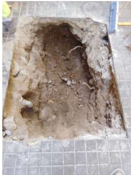
2. Cata de comprovació de serveis front el núm. 80.
