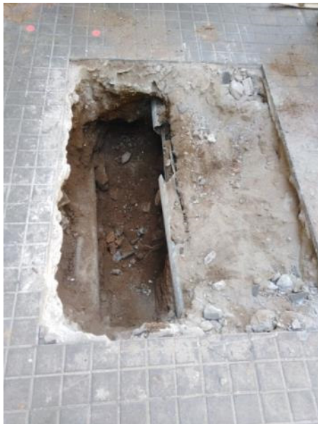
1. Cata de comprovació de serveis front el núm. 46
