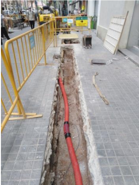
9. Vista general de la rasa front els núm. 72-56
