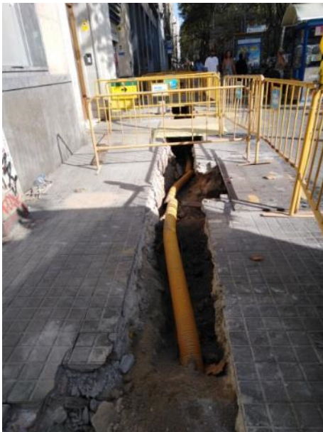
15. Vista general de la rasa front els núm.80-74
